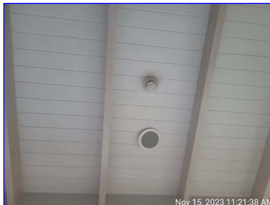
รูปที่ 2.28 อุปกรณ์ตรวจจับควัน
