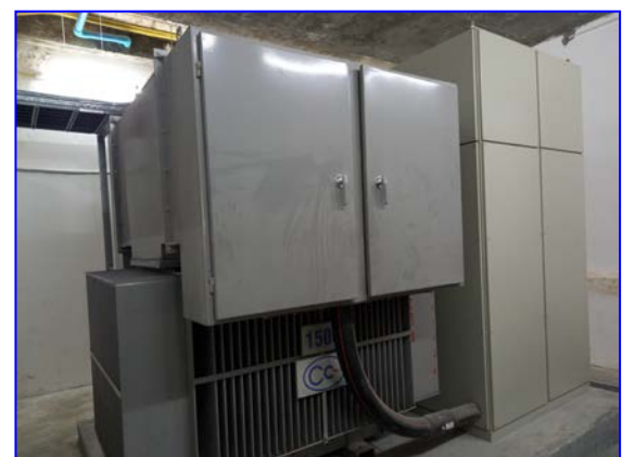
รูป 2.20 หม้อแปลงไฟฟ้า
