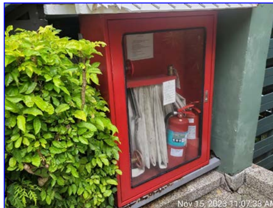
รูปที่ 2.25 ตู้เก็บสายฉีดน้ำดับเพลิง
